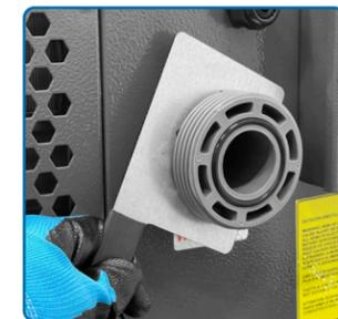
**3** Serrez le raccord de la pompe 1 avec la clé anglaise (schéma 12, G) comme montré sur le schéma. Protégez vos mains avec des gants.
